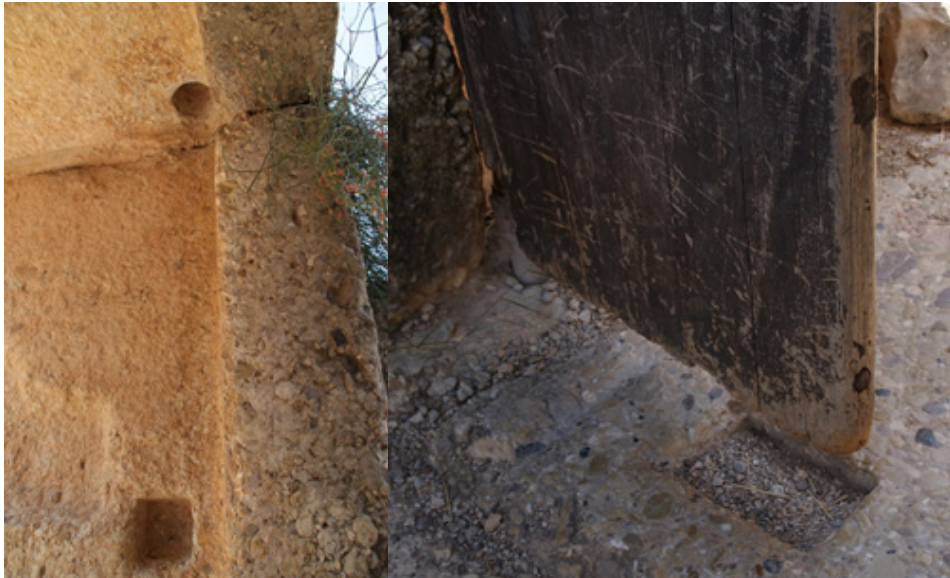
Рис. 3. Распашные ворота в Микенах. На изображении хорошо виден способ их крепления, а также расположение двух засовов, поперечного, который, очевидно, запирает обе створки одновременно, и двух вертикальных, фиксирующих створки снизу
